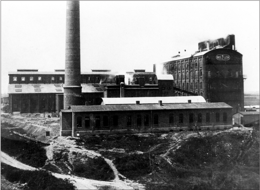
Gesamtansicht der späteren Brikettfabrik Carl mit ND-Kesselhaus, Kühlhaus und Werkstätten/Magazin um 1908, von der Ostkippe aus fotografiert.
