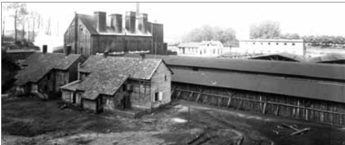
Zum Schutz vor Witterungseinflüssen und zum Auskühlen wurden die frischgepressten Briketts in überdachten Rinnen zur Verladung oder zur Stapelung in Schuppen gedrückt. Im Hintergrund sind Neubauten zu erkennen, so dass auf dem Foto vermutlich die Situation auf Sibylla gegen Ende der 1920er Jahre wiedergegeben ist.
