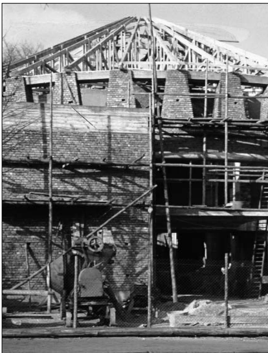
St. Severin im Rohbau (Foto 1956)
