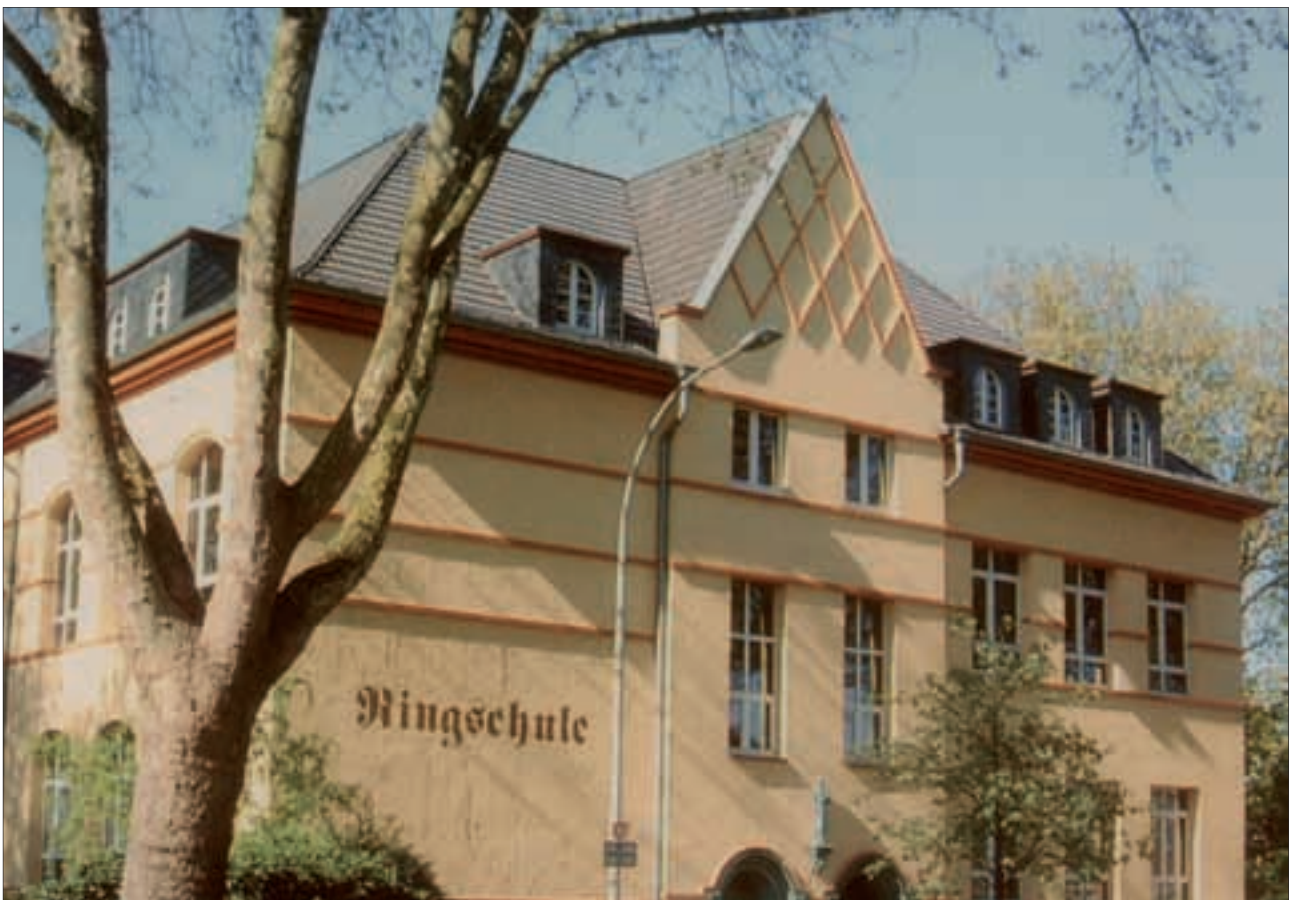
Ansicht der Frechener Ringschule, 2004 (Foto: R. Kleefisch, Frechen)
